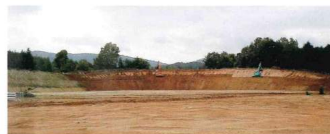
貯木場新設状況
