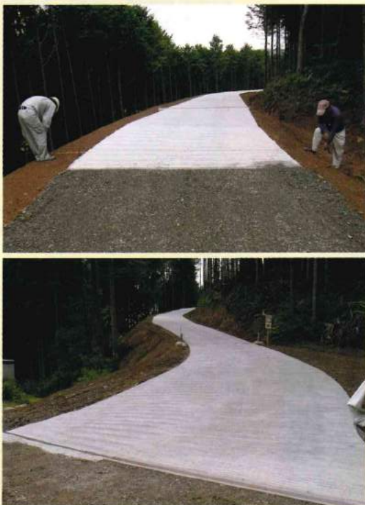
〈仙代線完成写真〉
